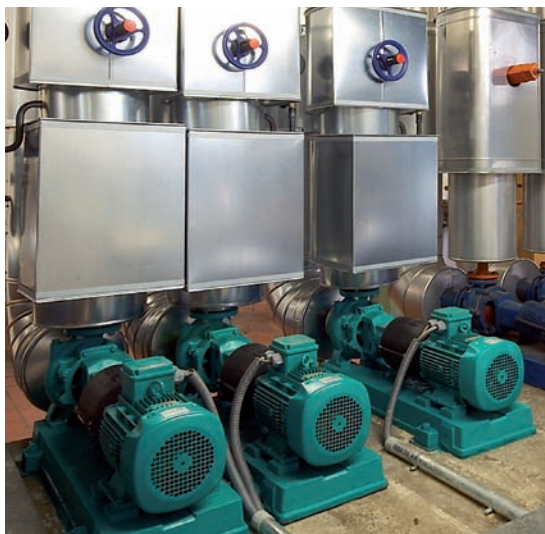
De op 16 juni 2011 in werking getrede verordening (EG) nr. 640/2009 van de EU-commissie regelt de efficiëntie van elektromotoren. Hiertoe behoren ook de elektrische aandrijvingen van droogloperpompen.
